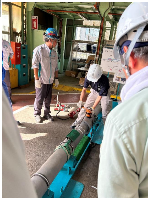
【接合実習 直管受口と直管挿し口】 接合（直管受口内へ挿し口を引き込む）
