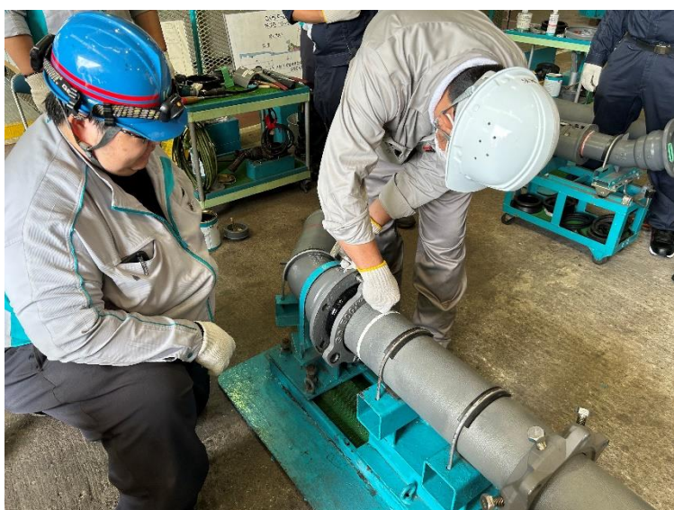
【接合実習 異形管受口と直管挿し口】 T頭ボルト・ナットの取り付け
