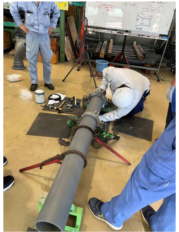
【接合実習 P-Link の取り付け】 P-Link を挿し口に引き込む準備
