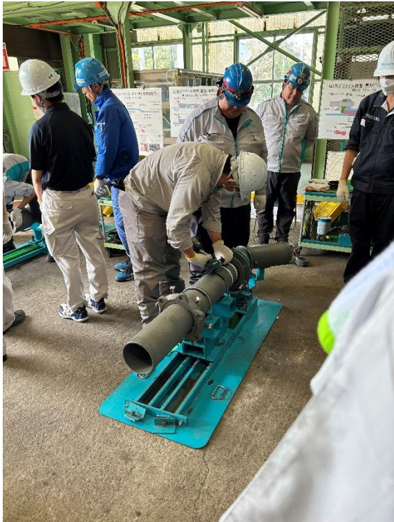
【接合実習 異形管受口と直管挿し口】 T頭ボルト・ナットの締め付け
