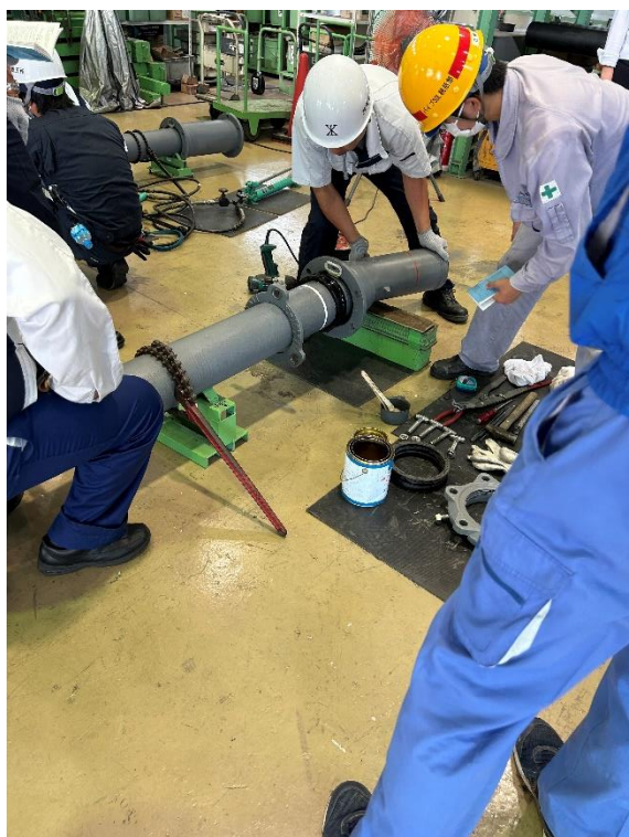
【接合実習 異形管受口と直管挿し口】 異形管の接合（異形管受口を挿し口に預ける）
