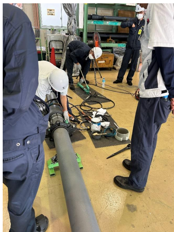
【接合実習 直管受口と直管挿し口】 継手の解体（油圧ジャッキを用いて解体）
