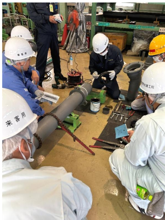
【接合実習 異形管受口と直管挿し口】 ゴム輪への滑剤塗布
