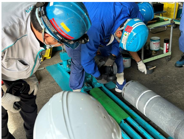
【接合実習 直管受口と直管挿し口】 直管受口へのゴム輪の装着
