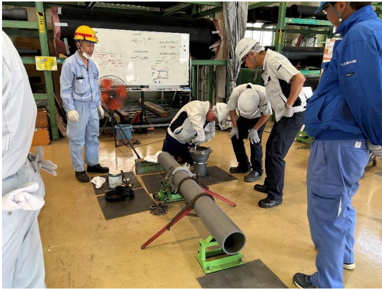
【接合実習 P-Link の取り付け】 のみ込み量の測定
