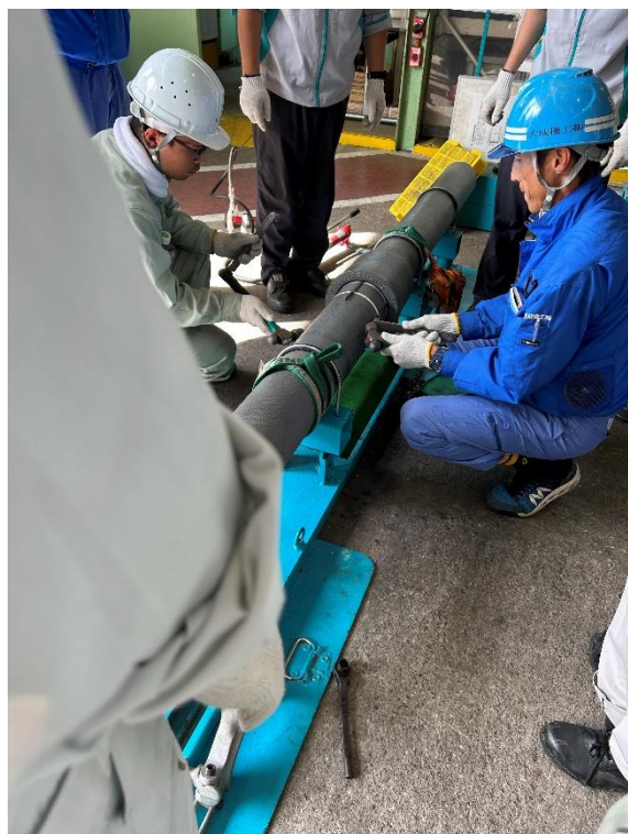
【接合実習 直管受口と直管挿し口】 継手の解体（解体矢の打ち込み）
