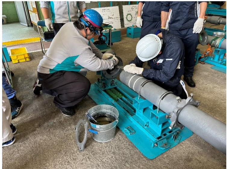
【接合実習 異形管受口と直管挿し口】 ストップの再セット
