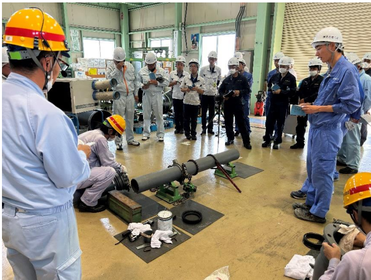
接合指導員による接合実演 (直管挿し口へのP-Linkの取り付け)
