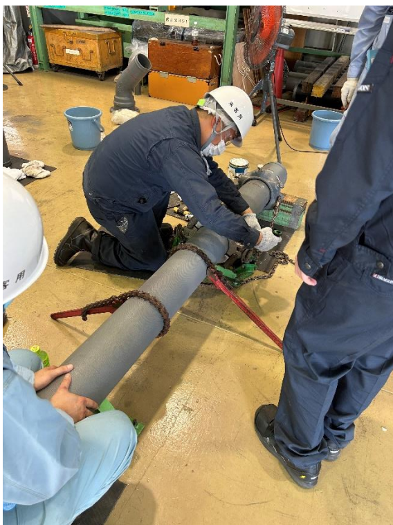
【接合実習 P-Link の取り付け】 P-Link を挿し口に引き込む準備
